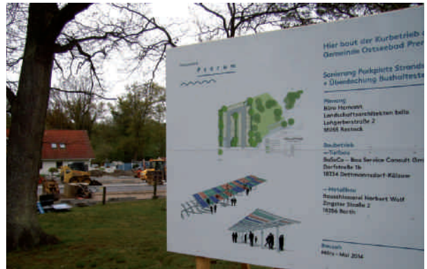
Bau der neuen Bushaltestelle an der Freien Schule
