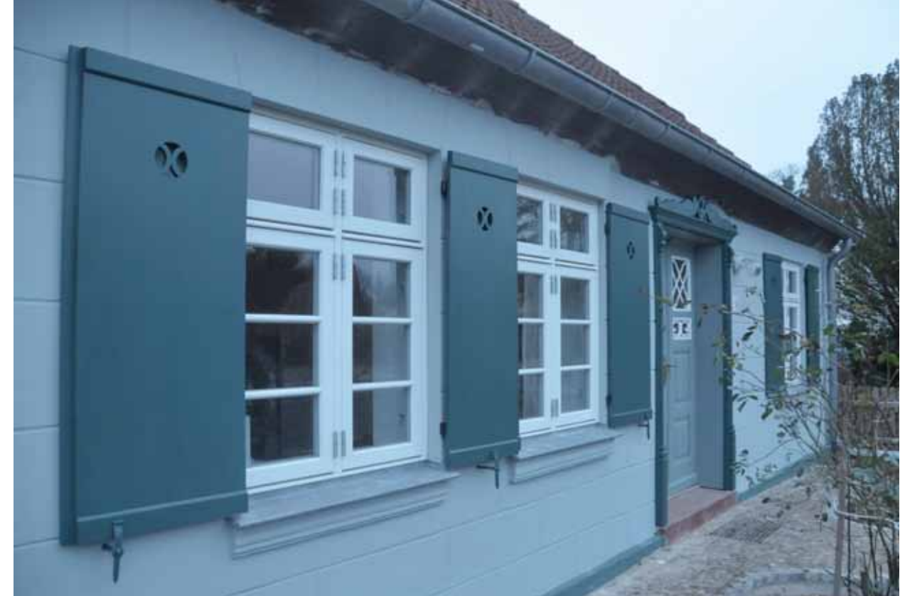
Born, Im Moor 14 - wiederhergestellte Fassade
