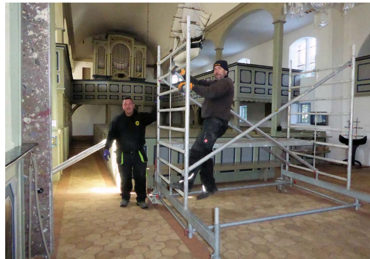
Ralf Dankert mit einem Mitarbeiter bei der Sanierung des Kirchinnenraums. Foto: privat
