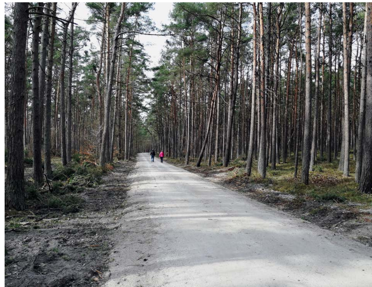
Der sanierte Leuchtturmweg. Foto: Heike Lawrenz
