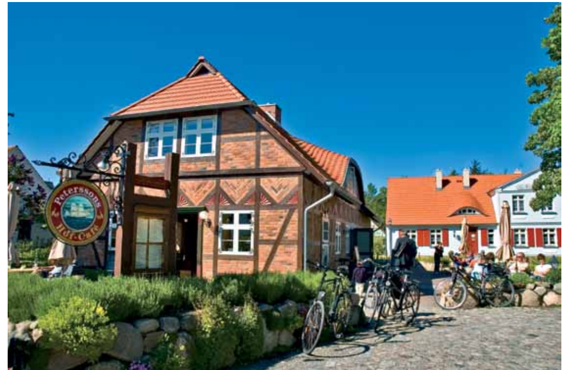
Peterssens Hof heute: links in der neuen/alten Scheune das Restaurant-Café, im Hintergrund das Haupthaus mit 5 Ferienwohnungen
