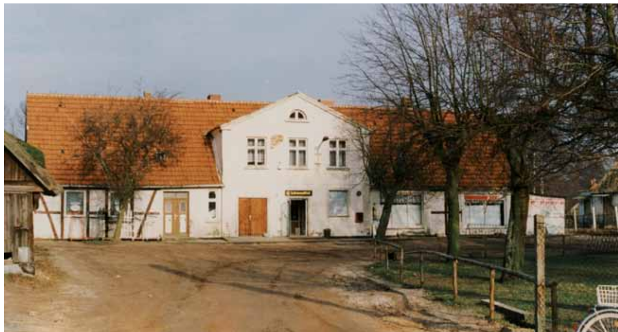
Das Grundstück Anfang der 1990er Jahre
