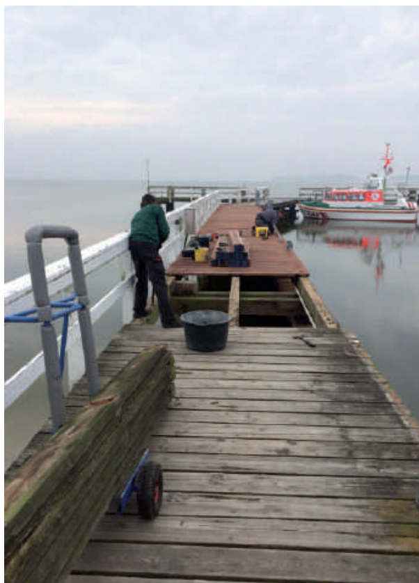
momentan wird die Wiecker Boddenbrücke repariert
