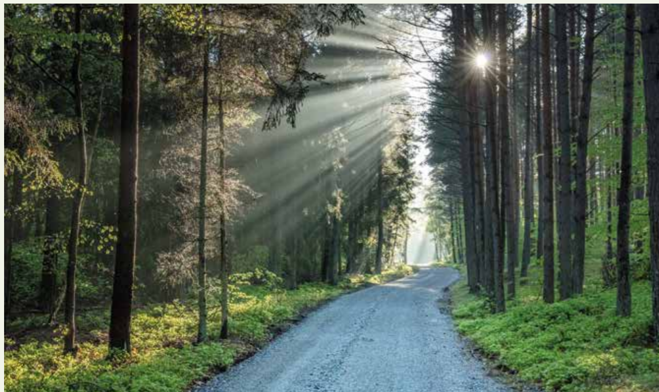
Erneuerter Waldweg im Nationalpark. Foto: Klaus Haase
