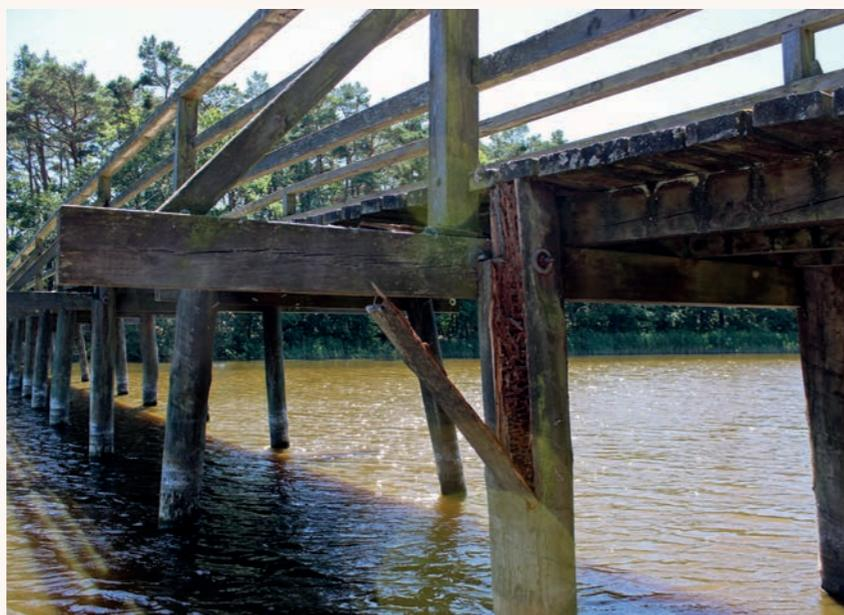
Zerstörung durch Braunfäule und Holz zerstörende Ameisen an den Brücken,
